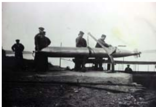
Klargöringsarbete med torpeden
