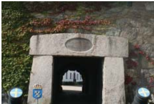
Kungsholms fort är idag slutet med IX linjer. Här syns Linje VII med ingång till fortets slutna del. Detta valv togs upp på 1870-talet. Den översta stenen i valvet, slutstenen, väger 16 – 18 ton, höggs på Tjurkö och transporterades till fortet. Foto Olle Melin
