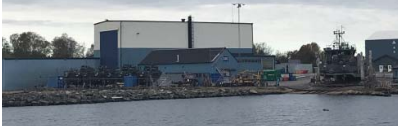
Varvsområdet med stora verkstadsbyggnaden och trossbåt på slipen. Foto Johan Melin
